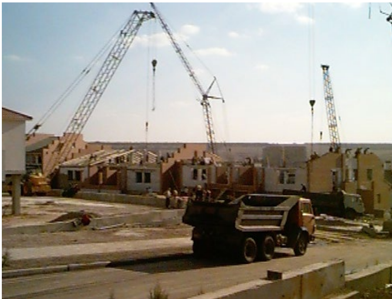
Prace budowlane w czasie trwania Olimpiady w Eliście © Archiwum Kuriera Szachowego
